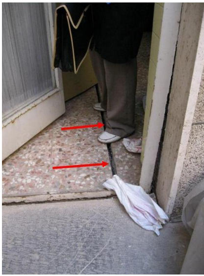
تصویر شماره ۸- ترک ایجاد شده در موزائیک کف حیاط، در اثر گودبرداری در نزدیکی ساختمان
