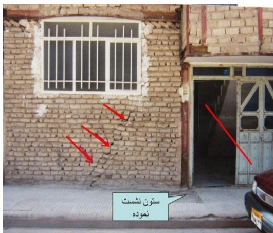
تصویر شماره ۴- ترک ایجاد شده در دیوار خارجی ساختمان، در مجاورت شکستگی لوله آب
