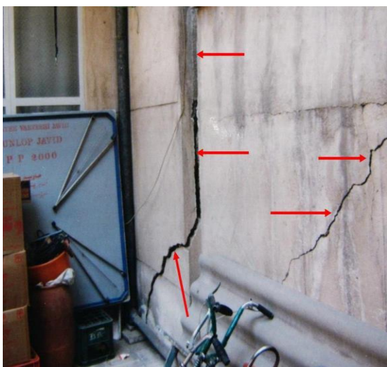
تصویر شماره ۳- ترک های ناشی از نشست ساختمان در دیوار حیاط و در ساختمان مجاور
